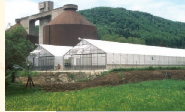
Kläranlage Albstadt (DE)
