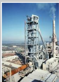
PREHEATER EXHAUST FAN
