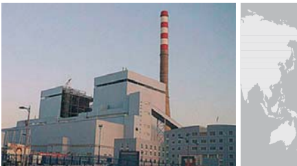
CHINA: TUOKETUO POWER STATION
